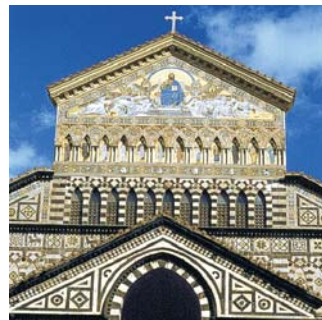
Amalfi, Detail Domfassade
